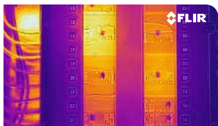
Connexion desserrée
